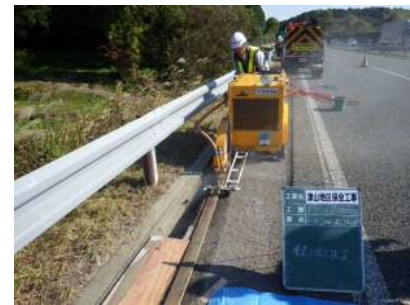
① 天端スラブ部垂直切断
