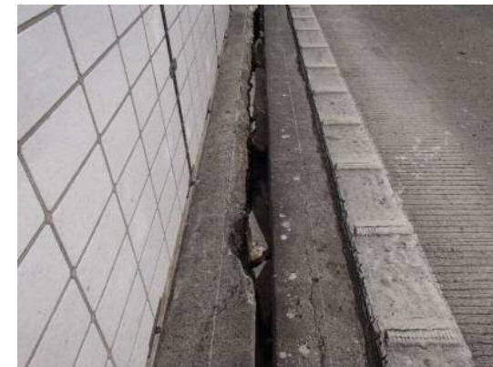
トンネル部 施工前
