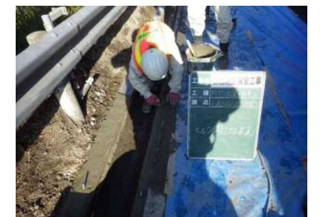
⑤-2 調整モルタル敷き均し
