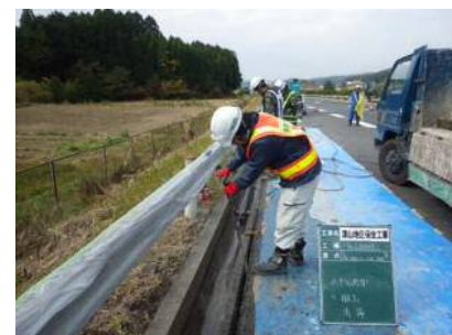
④ 側壁部廃材撤去
