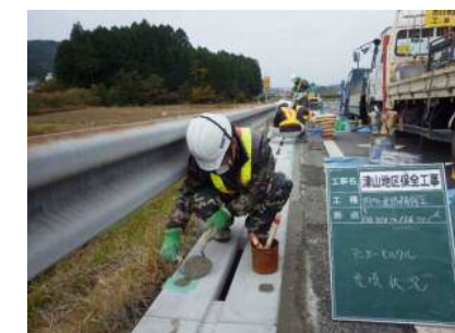
⑥ 間詰めモルタル
