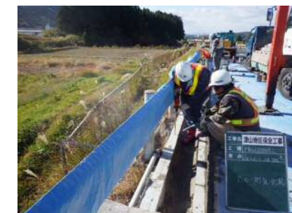
⑤-1 アンカー削孔状況
