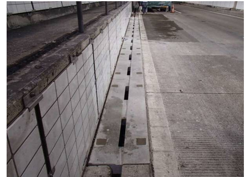
トンネル部 施工後
