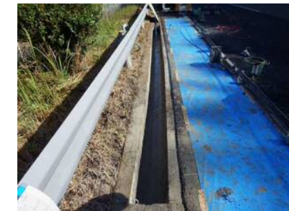
② 天端スラブ部廃材撤去
