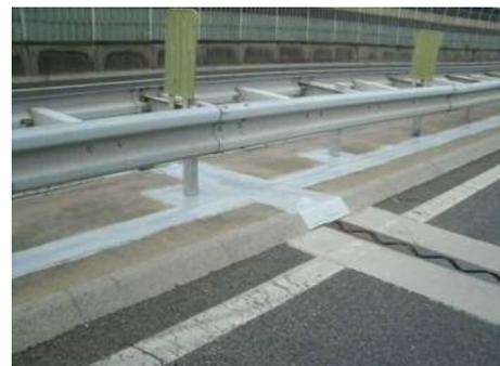
ジョイント目地とガードレール支柱根元の閉塞
