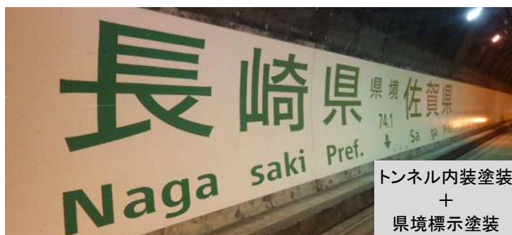
トンネル内装塗装 + 視線誘導ライン塗装
