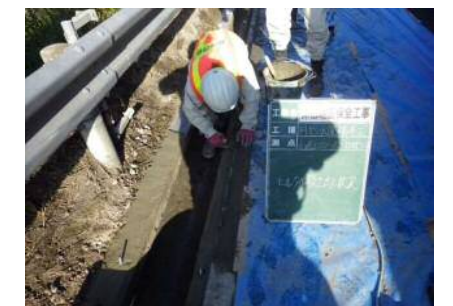
⑤-2 調整モルタル敷き均し
