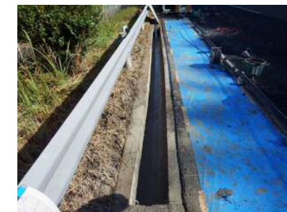
② 天端スラブ部廃材撤去
