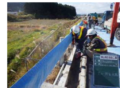
⑤-1 アンカー削孔状況
