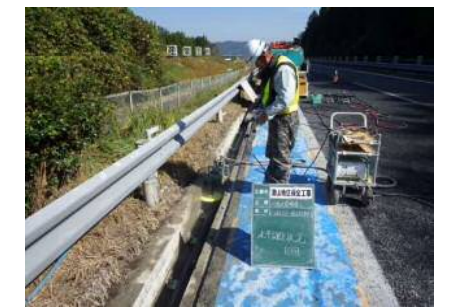
③ 水路水平切断
