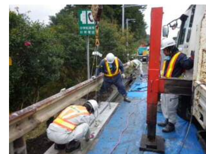
⑤-3 蓋版据付け
