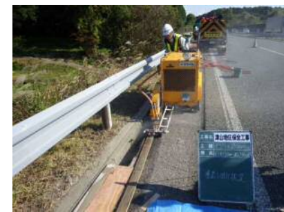
① 天端スラブ部鉛直切断
