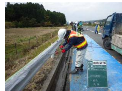
④ 側壁部廃材撤去
