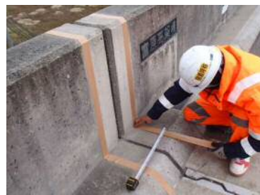
墨出・養生工
