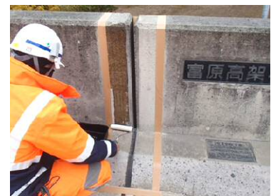
プライマー工
