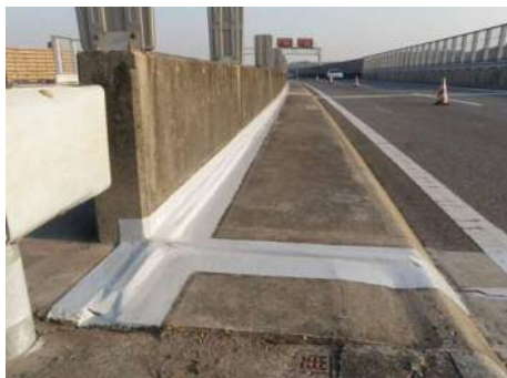
中央分離帯の遊間防水
