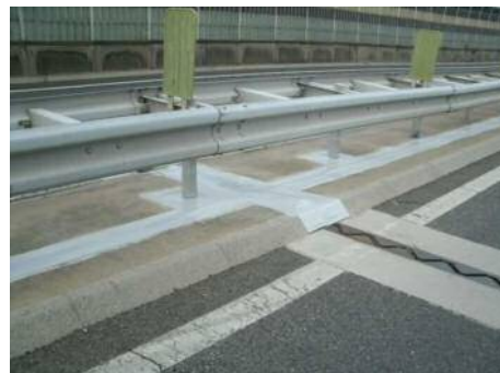
ジョイント目地とガードレール支柱根元の防水
