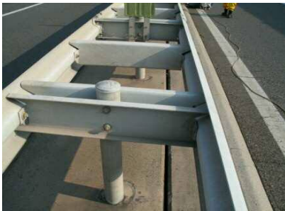
中央分離帯の遊間部分
