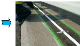
バックアップ工
