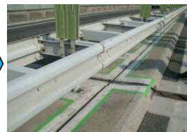
墨出・養生工
