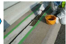
プライマー工
